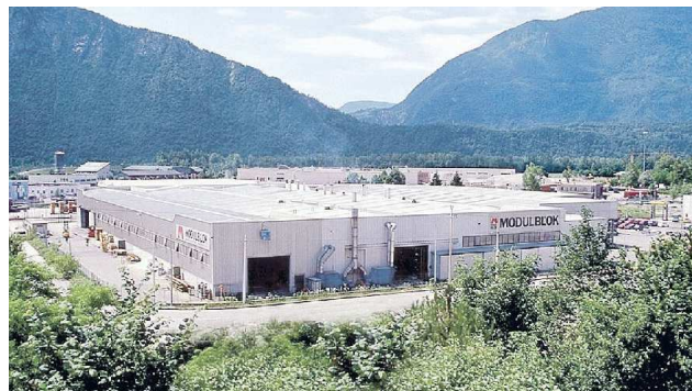
MODULBLOK Lo stabilimento friulano conta 129 dipendenti: il fatturato è di 45 milioni
